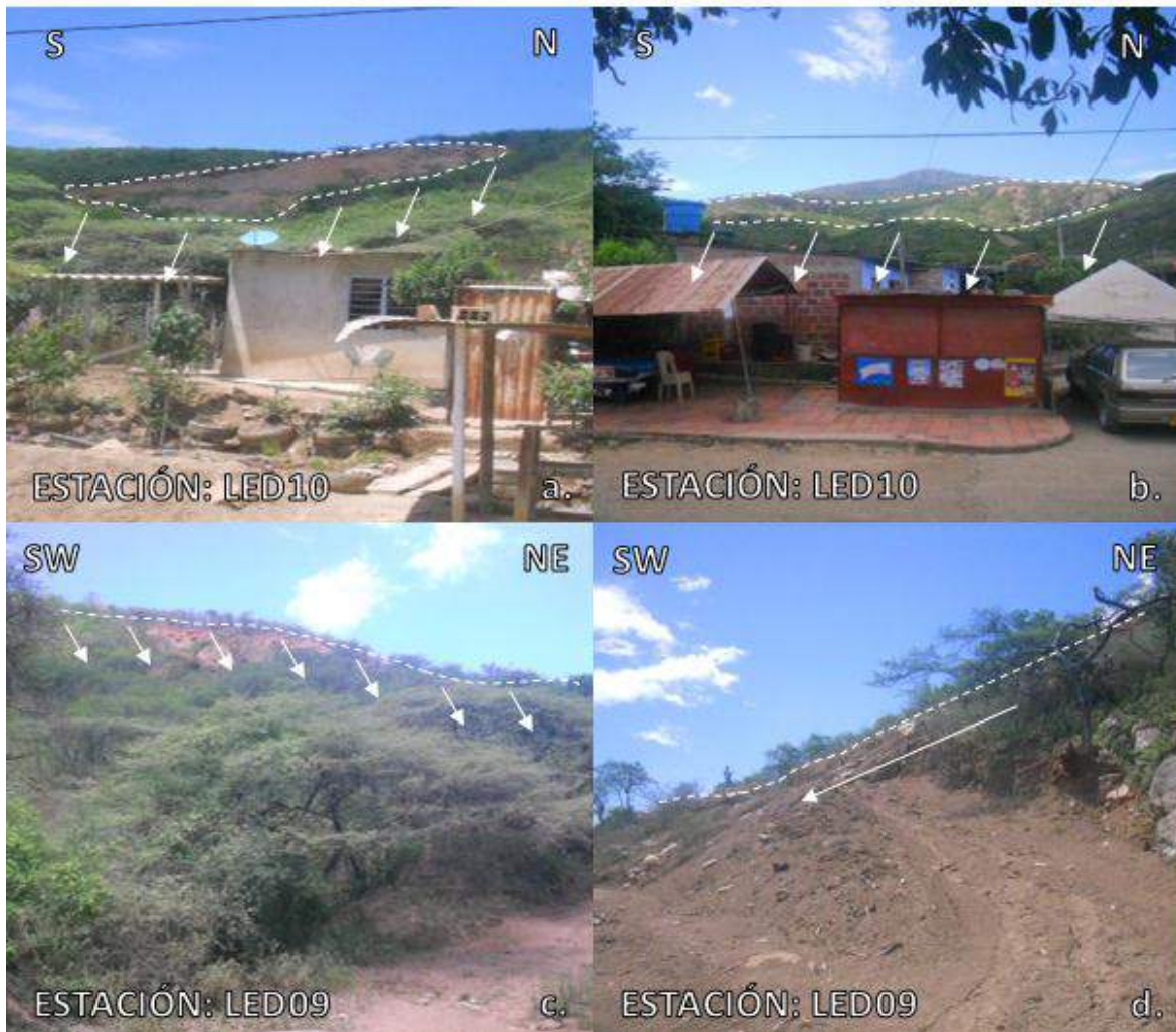
Gráfica 144. Deslizamiento rotacional reportado en San Pedro. a y b) Estación LED10, coordenadas: N=1.356.795, 083 m, E= 840.493, 189 m. c y d) Estación LED09, coordenadas: N= 1.357.087, 808 m, E= 840.494, 195 m
