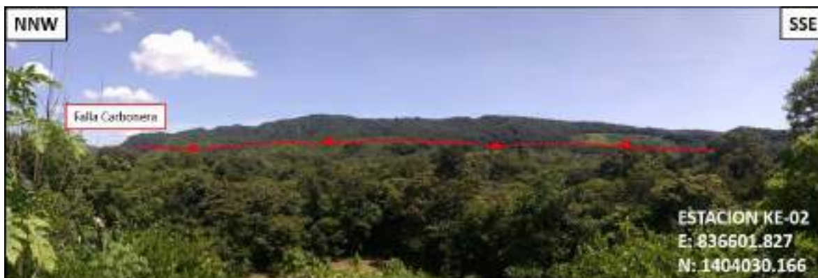
Gráfica 76. Falla Carbonera hacia el sector oeste de la Cuchilla Carbonera en el norte del área rural del municipio de San José de Cúcuta.
