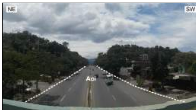
Gráfica 147. Obras de Ingeniería (Aoi).. Imagen tomada a la Autopista La Atalaya la cual corta el cerro Atalaya.
