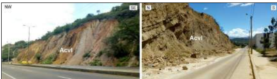
Gráfica 144. Corte vertical de Ladera (Acvl) en las zonas de expansión. . Izq. Fotografía tomada al corte realizado al extremo de la prolongación de la Avenida Cero que comunica con el municipio de Villa del Rosario. Der. Fotografía tomada al corte realizado sobre una vía de acceso a las torres de Los Arrayanes.
