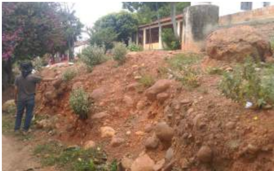
Gráfica 56 Suelo transportado aluvial de terraza alta de gravas con Cantos (Stata2)
