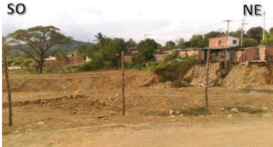
Gráfica 68 Lleno del antiguo cauce de la quebrada La Cañada con material antrópico. E 839.318 m, N 1'366.041 m, WTP_0000287.
