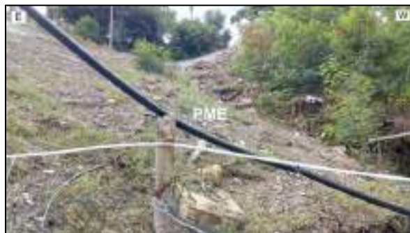
Gráfica 139. Pendientes muy empinadas del casco urbano del municipio de Cúcuta
