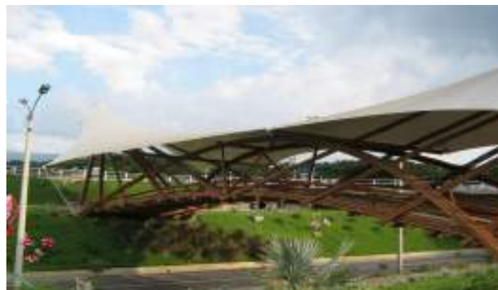
Figura 19. Puente de guadua Arnulfo Briceño
