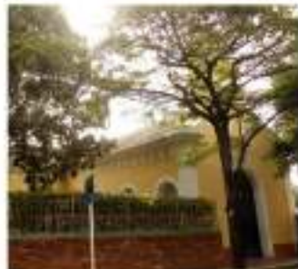
Casa y capilla Asilo Andressen
