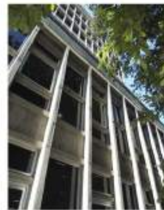
Antiguo edificio Banco de la República
