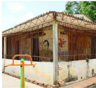
Estación Puerto Villamizar
