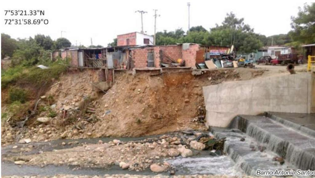
Gráfica 23. Caída de bloques y socavación lateral de la quebrada la Cañada.
