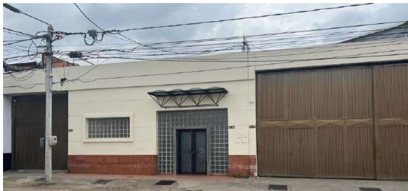
Bodega área de Archivo Central - Av2 #15-16 barrio La Playa
