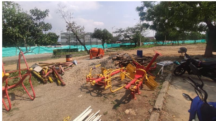
Figura 6-81 Inicio Obras Fase 2 – Av. Sevilla
