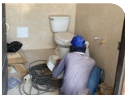
✓ Instalación de aparatos sanitarios de caseta.
