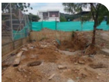
✓ Excavación zapatas camerinos.
