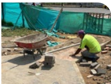
✓ Instalación adoquín puente existente.
