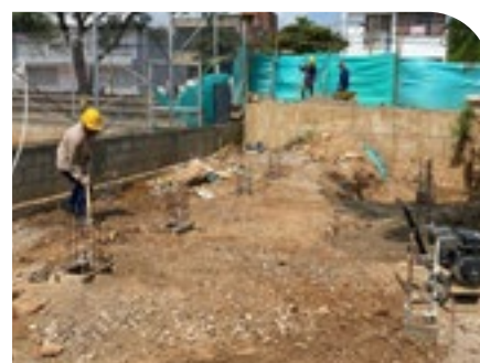
✓ Excavación pedestales y fundida pedestales.
