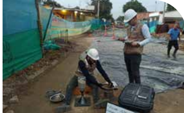
✓ Se realiza la tomas de ensayos de compactación.
