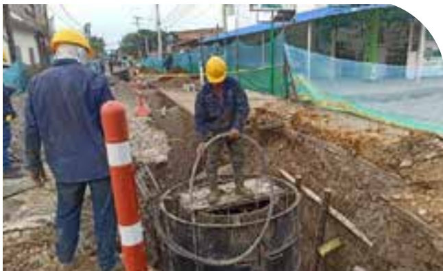
✓ Fundida y Vibrado MH -12.
