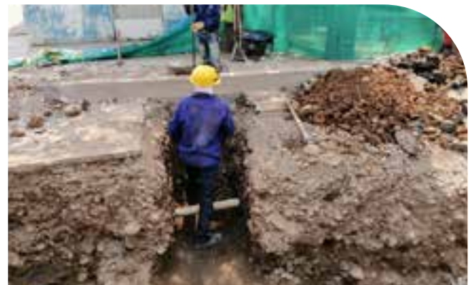
✓ Excavación para acometidas.
