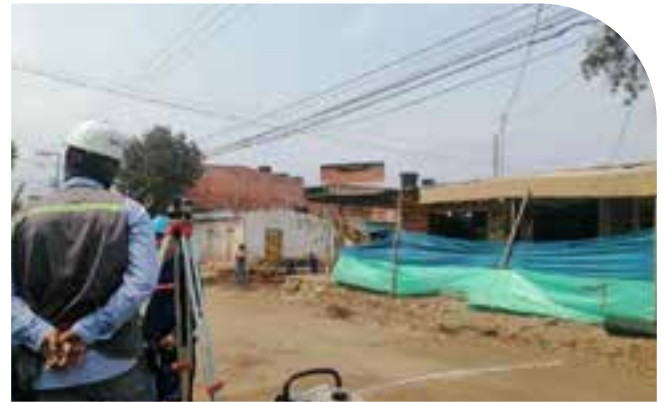
✓ Chequeo de niveles de la intersección #3.
