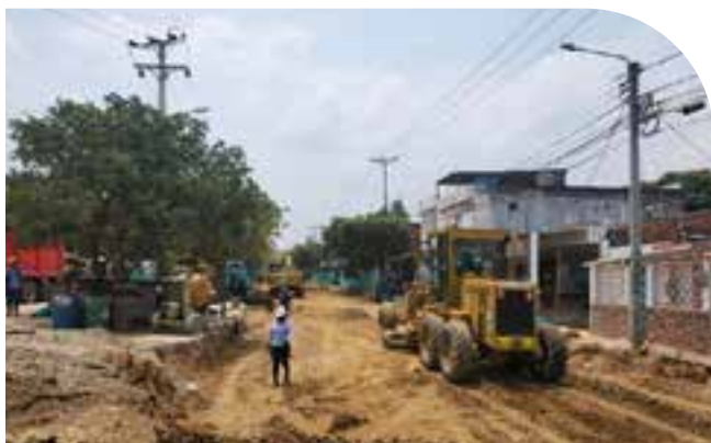
✓ Conformación de la subrasante
