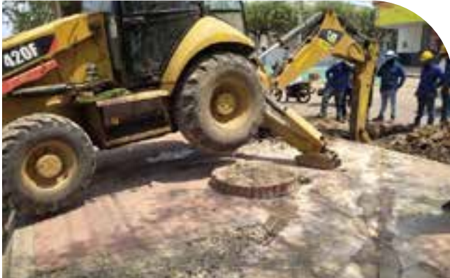
✓ Excavación para tubería de 12 pulg de los sumideros s 113 y s88 al pozo 201.
