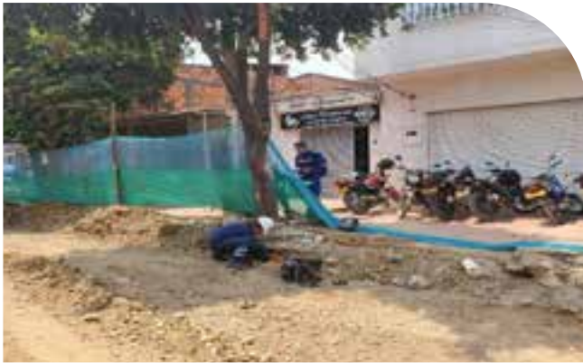
✓ Excavación manual para profundizar tubería de gas muy superficial.
