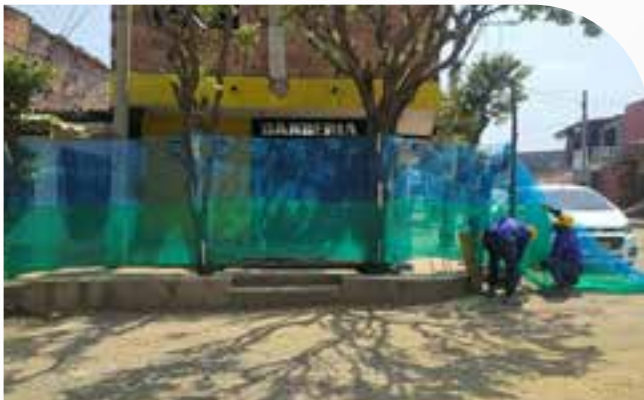
✓ Instalación de cerramiento de obra.
