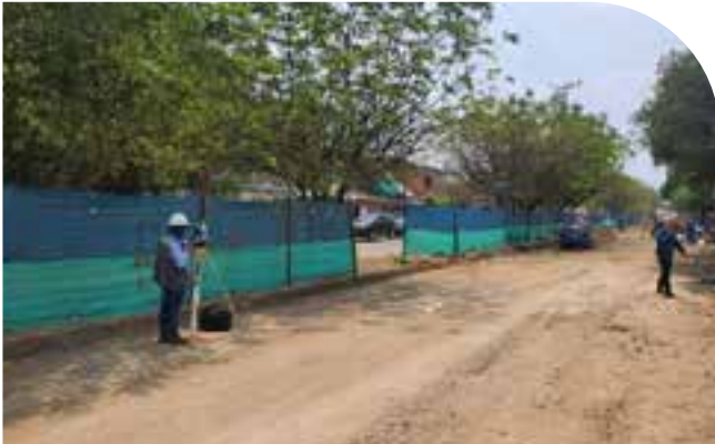
✓ Replanteo de anchos de vía.
