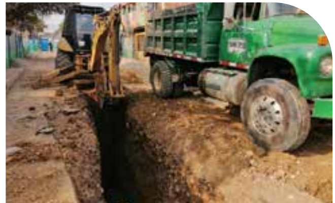
✓ Excavación para instalación de tubería sanitaria.
