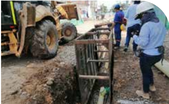
✓ Instalación de tubería sanitaria, y lleno con triturado,
