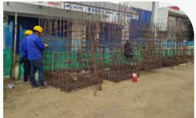
✓ Amarre de acero de refuerzo sumideros de aguas lluvia.
