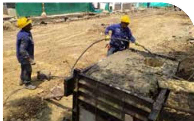
✓ Fundida y vibrado de tapa sumidero S-96
