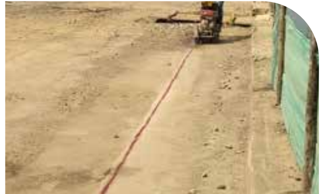
✓ Replanteo de anchos de vía.
