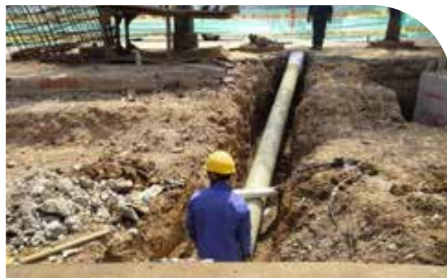
✓ Instalación de tubería de 12" del Sumidero S-41 al pozo HM-226.
