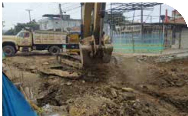
✓ Excavación caja estructura de pavimento K2+060
