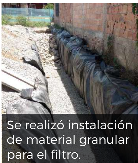
Se realizó excavación para el filtro perimetral.
