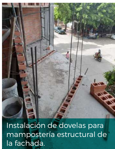
Construcción de mampostería en ladrillo estructural para la fachada del proyecto.
