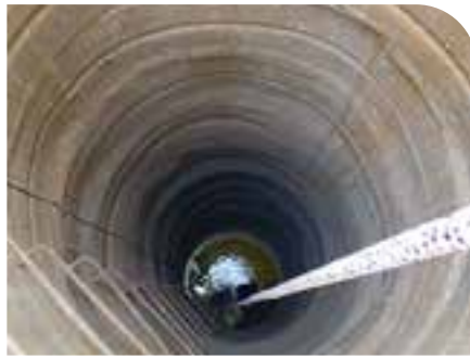
✓ construcción de pozo de riego. h: 12,5 m
