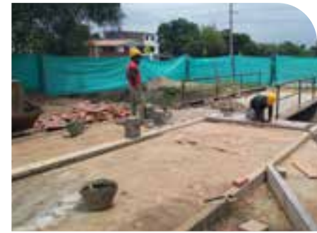
✓ Instalación de adoquín..
