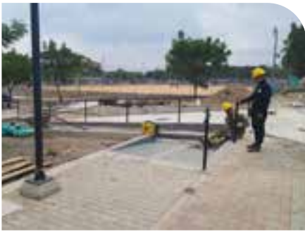
✓ instalación de pasamanos.
