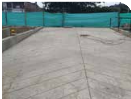
✓ Construcción rampa principal.
