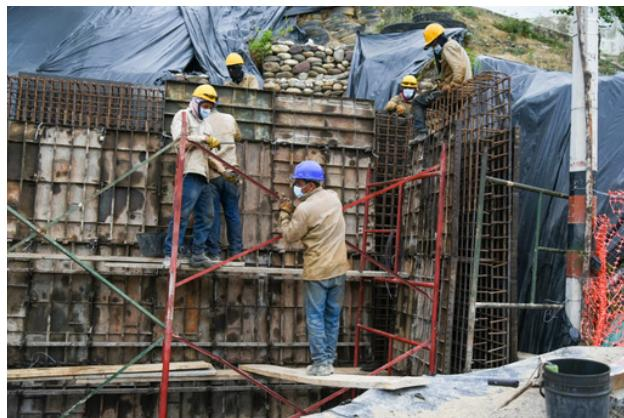
Adicionalmente, se han ejecutado actividades correspondientes a gestión predial, demolición de elementos en mampostería y concreto, instalación de anclajes activos en el talud y figurado de acero de refuerzo.
