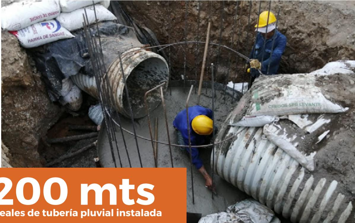
A causa de la ola invernal en la Av. Américas, el contratista de obra utilizó, en el proceso constructivo, un concreto con acelerante para mejorar el fraguado y lograr un secado más eficiente para las bases de los pozos pluviales, el cual es un gran beneficio para la estabilidad de la obra, y así, no generar más atrasos.
