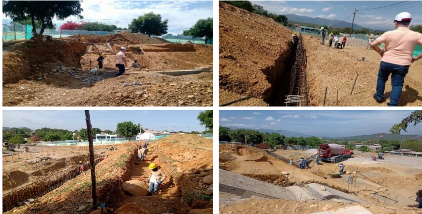
Imagen 24: Excavación de la estructura de la segunda y tercera terraza
