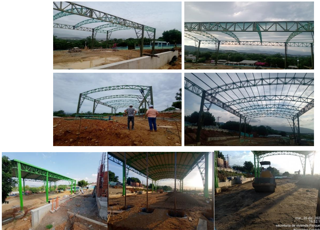
Imagen 26: Instalación de estructura de cancha
