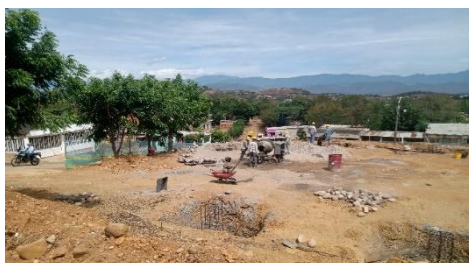
Imagen 23: Excavaciones varias para la construcción de las zapatas de la cimentación que hacen parte de la estructura de la cubierta.
