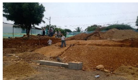
Imagen 23: Excavaciones varias para la construcción de las zapatas de la cimentación que hacen parte de la estructura de la cubierta.
