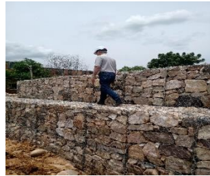
Imagen 17: Observamos en la visita de obra la construcción del solado de protección para la instalación sobre este de la malla eslabonada galvanizada de 8*10 para construir los gaviones en piedra seleccionada.
