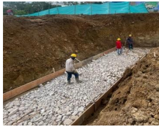
Imagen 17: Observamos en la visita de obra la construcción del solado de protección para la instalación sobre este de la malla eslabonada galvanizada de 8*10 para construir los gaviones en piedra seleccionada.
