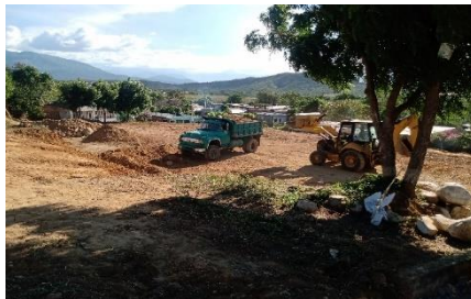
Imagen 22: Descapote y replanteo
