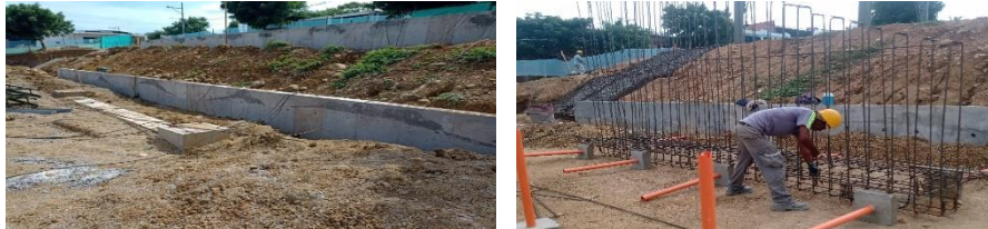
Imagen 25: Terminación de fundición de muros
