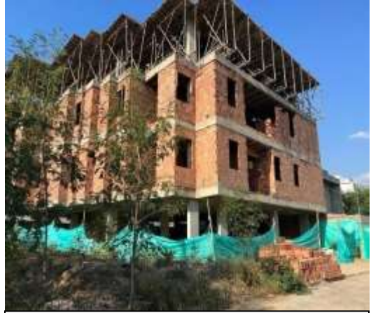
Inspección de obra con licencia, Niza.
