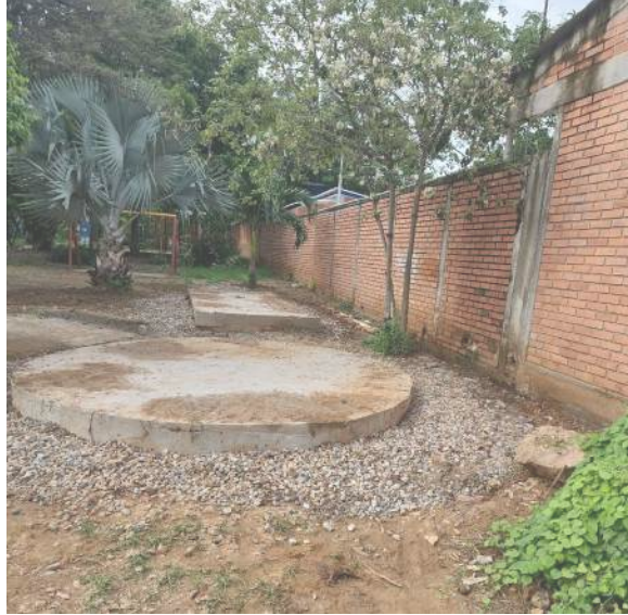
Construcción de pozos sépticos cumpliendo con lo estipulado en los planos aprobados
