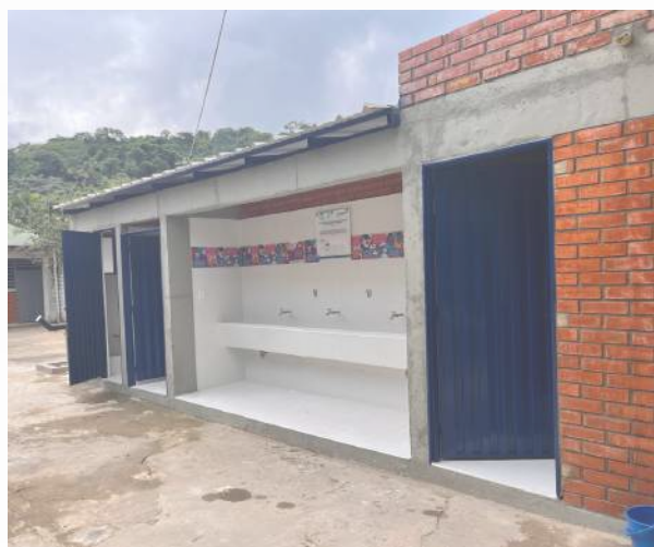
Construcción de planta física de las baterías sanitarias de NNAJ
